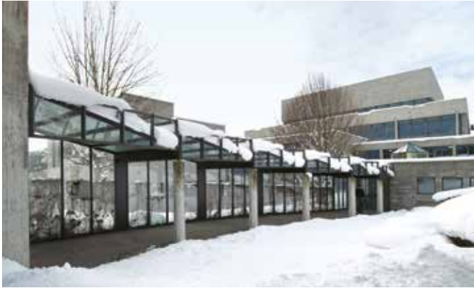
Der transparente Verbindungsgang vom Haupt- zum Bibliotheksgebäude
