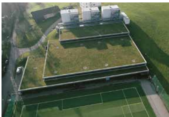
Terrassenbau Sporthalle mit Sportplatz
