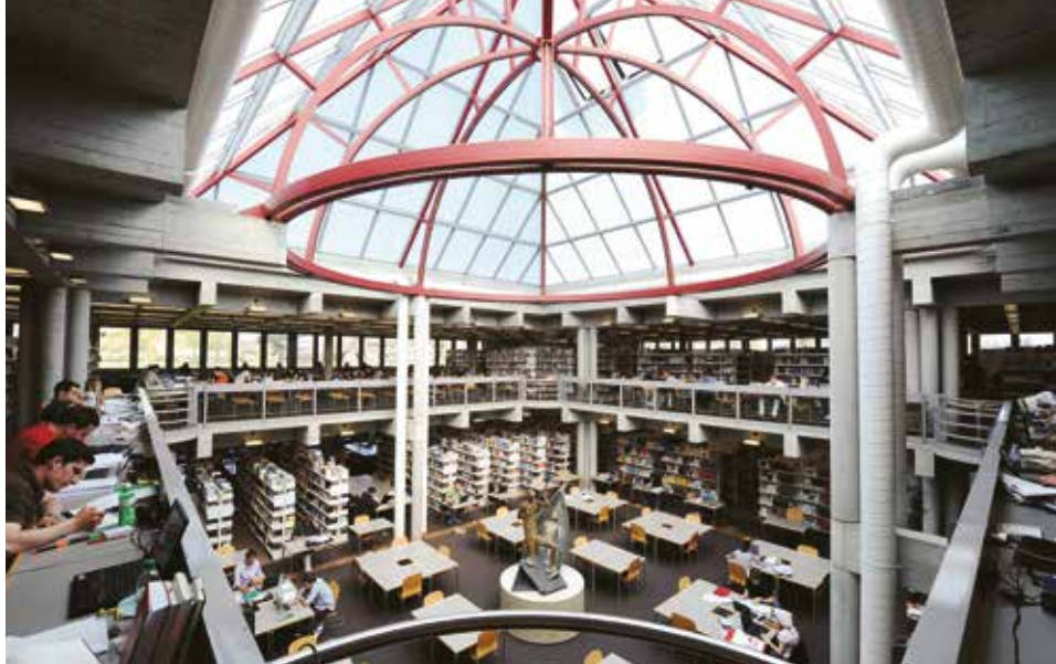
Unter der grossen Glaspyramide und einer kuppelförmigen Stahlträgerkonstruktion befindet sich die Bibliothek
